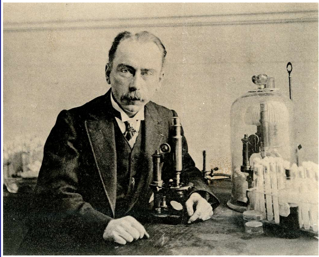
Figure 2 : Le microscope avec lequel Jules Bordet est photographié ici en 1920 est un modèle prestigieux de chez Carl Zeiss. Ce haut de gamme se distinguait par un nouveau système de mise au point fine, plus ergonomique et plus précise. Surnommé " Bierseidel " en raison de sa poignée qui fait penser à une chope de bière fut commercialisé de 1898 jusque dans les années 1920. Les objectifs apochromatiques et oculaires appariés, préférables à toute autre combinaison, sont plus onéreux que ceux des gammes ordinaires. © Institut Pasteur de Paris/Archives Jules Bordet, avec permission.
